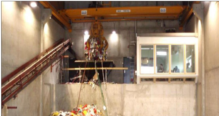
Ryc. 15. Przykład realizacji bunkra z suwnicą i chwytakiem łupinowym
